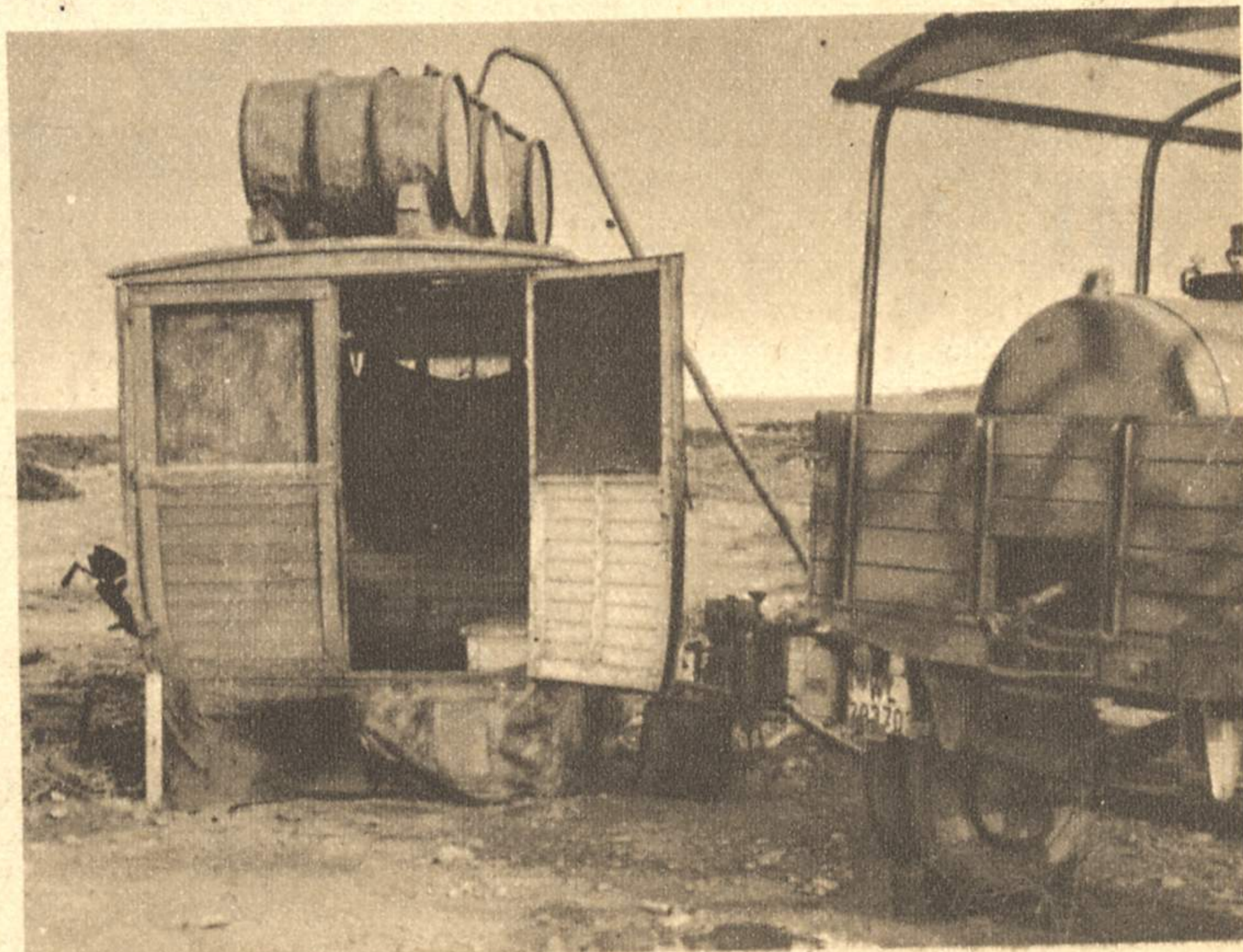
Rechts: Ein ausgedienter Lastwagen, drei Fässer, eine Pumpe und der gute Einfall eines deutschen Soldaten ließen ein Brausebad mitten in der Wüste erstehen
